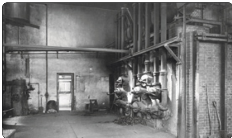
Původní plynárenské pece s vodorovnými komorami
