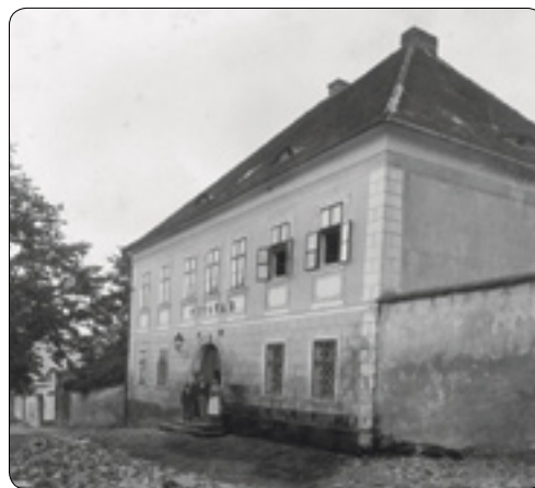
Pohled na pivovar z Dobrovského ulice (kolem r. 1890) ještě před úpravou fasády podle návrhu arch. Karla Pokorného v historizujícím stylu upomínajícím na podobu domu v 18. století, zřízením předzahrádky, vjezdu a stavbou vrátnice provedenými v l. 1906–1907
