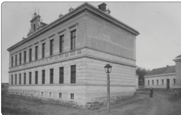
Hlavní budova hospodyňské školy krátce po dokončení v r. 1901.
