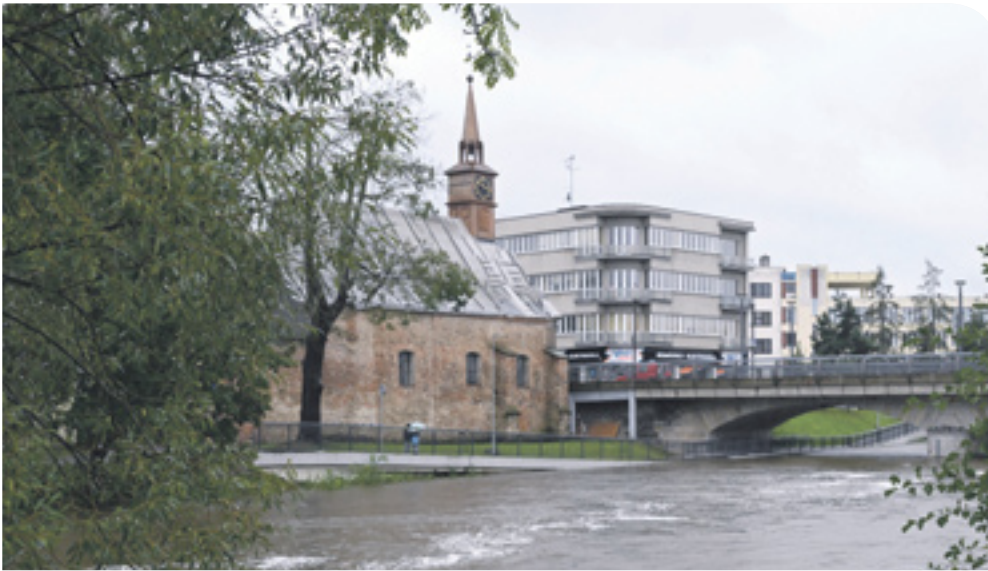
Během katastrofální povodně v roce 1714 poskytl zatopený kostel sv. Kateřiny útočiště místním.
