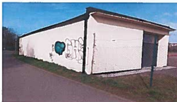
Jižní zeď skladu u cyklostezky Na Losích
